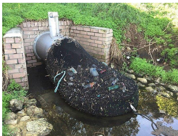
ภาพที่ 4 การติดตั้งถุงตาข่ายดักขยะที่ปากท่อระบายน้ำ
