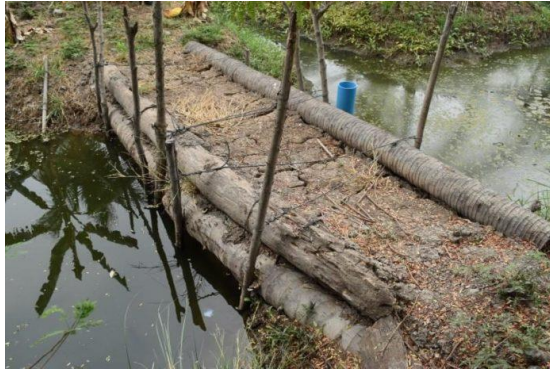
ภาพที่ 1 ภูมิปัญญาชาวบ้านในการสร้างฝายป้องกันน้ำเค็มรุกล้ำเข้าพื้นที่การเกษตร
